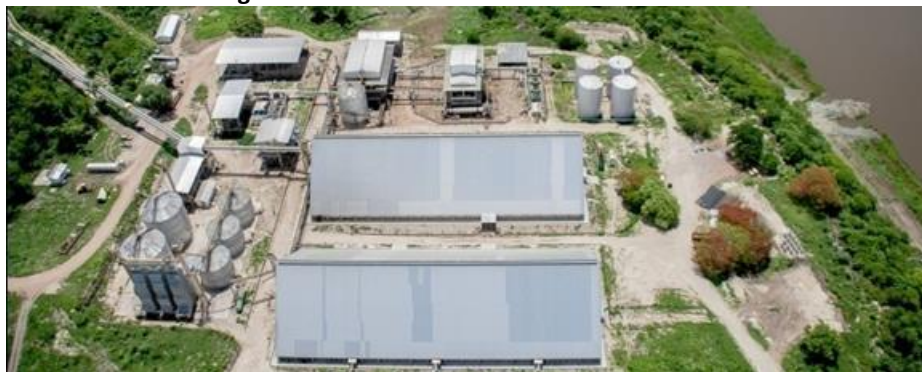
Gráfico No. 8 Fotografías Aéreas de la Planta de extracción instalada NUTRIOIL
