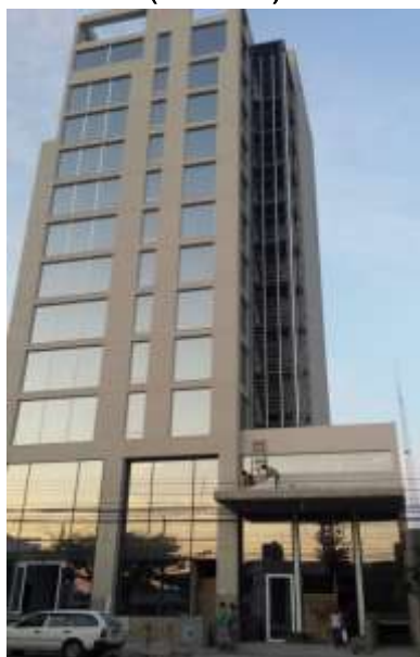
Fotografía 1. Avance de Obra (30/09/2015)
