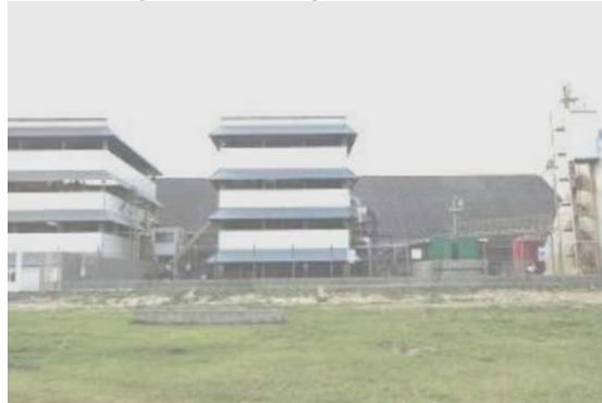
Fotografía 2: Vista general de la Planta
