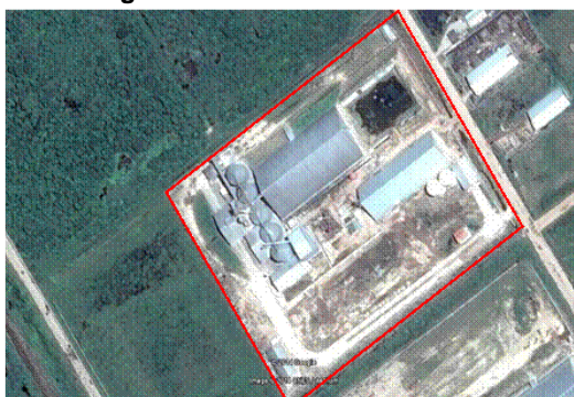
Fotografía 1: Vista satelital de la Planta
