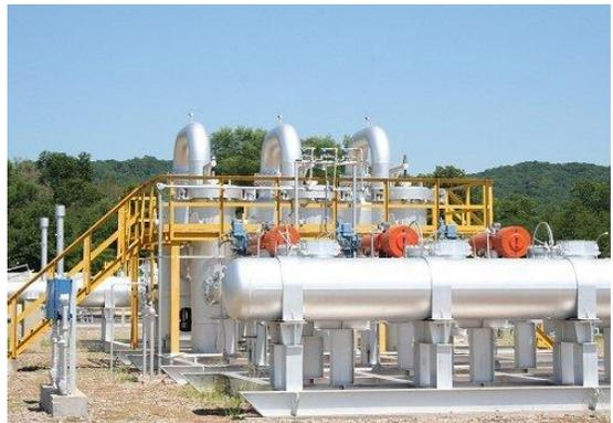
La cañería utilizada tiene la especificación API 5L X-70, revestida con polietileno extruido tricapa e internamente con pintura epóxica para aumentar la eficiencia del transporte por reducción de la fricción. La principal función del revestimiento externo es proteger el tubo de la corrosión para lo cual también se instaló un sistema de protección catódica de corriente impresa a lo largo de todo el gasoducto.
