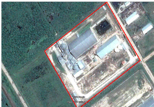
Fotografía 1: Vista satelital de la Planta
