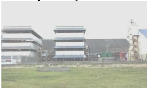
Fotografía 2: Vista general de la Planta
